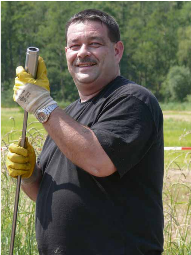
Montage der Rammverpresslanzen
